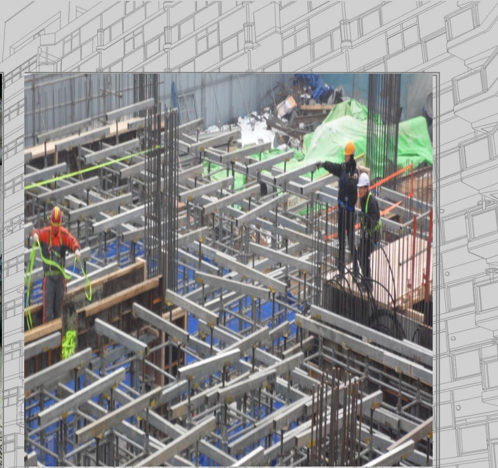
[ 가시설 설치 안전점검 ]
